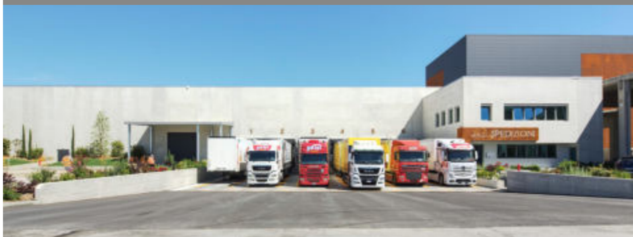
Panealba srl Cherasco (CN) | Fabbricato industriale con sistema costruttivo GEODIECI.
