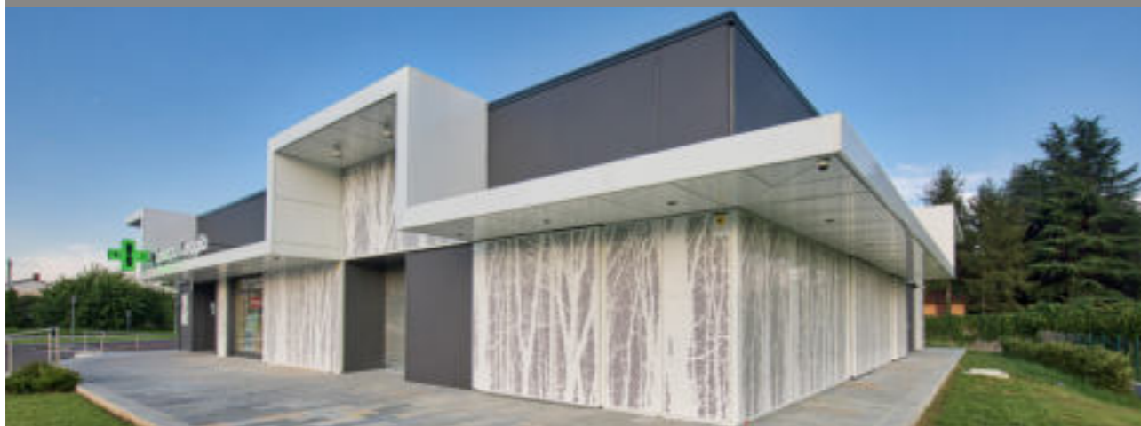
G.G.E. S.S. Cumiana (TO) | Rivestimento di facciata costituito da pannelli in alluminio preverniciato forato.
