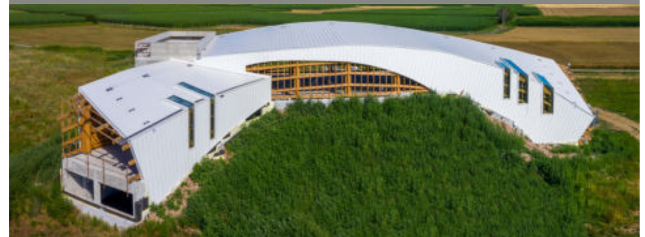
V.I.C.O. Srl Villareggia (TO) | Fabbricato uso cantina con tetto e pareti in legno lamellare.
