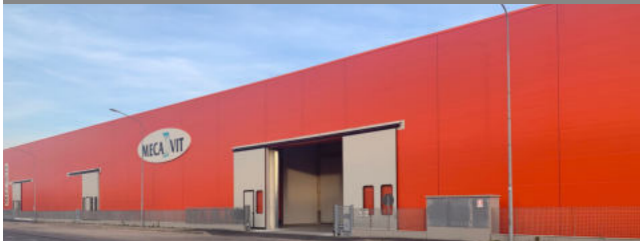
Mecavit Srl Castel Guelfo di Bologna (BO) | Fabbricato industriale con struttura in acciaio zincato.
