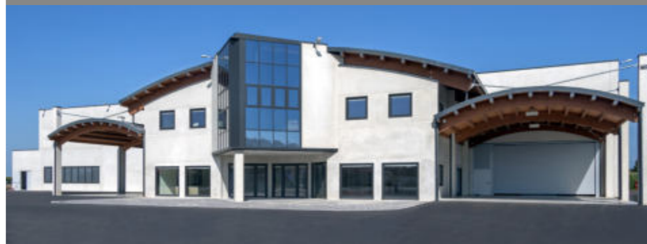
Greppi Srl Tronzano V.se (VC) | Copertura con lastre curve in acciaio, posate su strutture in legno lamellare.
