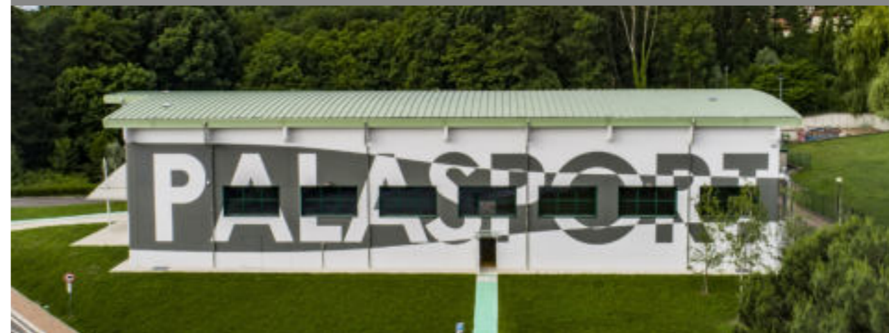
Impresa Cresta Spa Paruzzaro (NO) | Fabbriato sportivo con sistema costruttivo GEOLEGNO.
